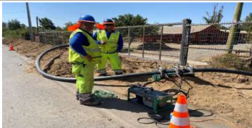
Instalación de tuberías: calle Chile Nuevo
