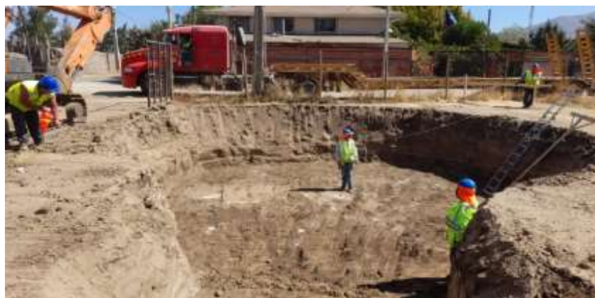
Excavación: estanque semienterrado en recinto.
