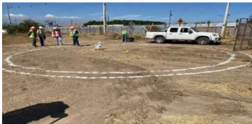
Nivelación y trazado estanque semienterrado en recinto.
