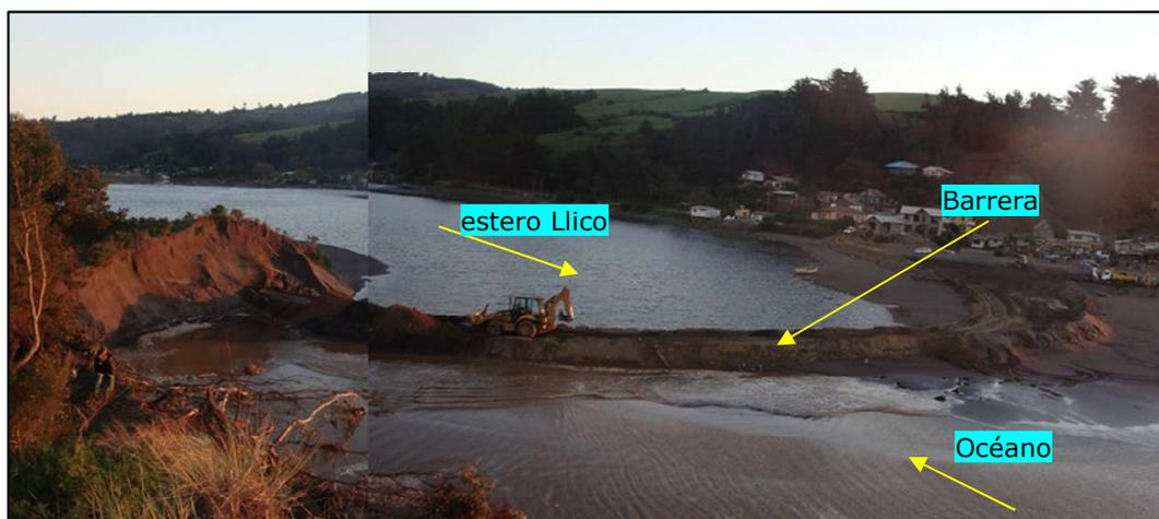
**Fotografía N° 1.** Barrea en desembocadura del estero Llico en construcción, año 2009.
