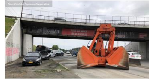
Imagen 02: Publicación viernes 20 de noviembre 2020, accidente puente Perales. Fuente: Radio Cooperativa web.
