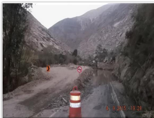
Km. 12,500. Sector bajo el nivel de agua del río, inundado.
