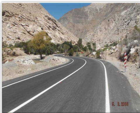
Sector terminado con rasante elevada.
